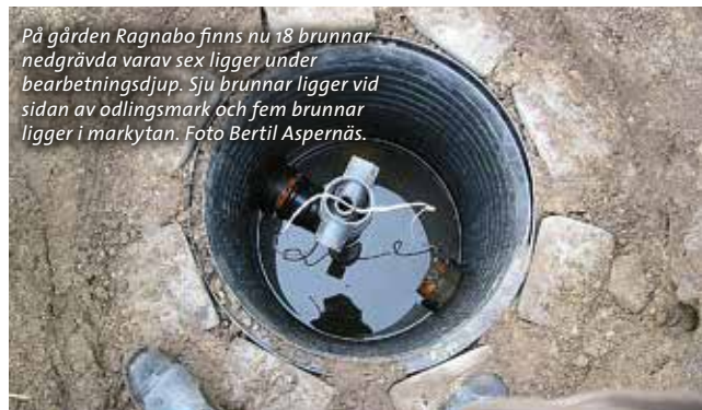
Med hjälp av ett rep reglerar Bertil Aspernäs vattennivån i de dämningssystem som ligger under markytan och därmed även i marken. Inför vårbruk och skörd sänker han nivåerna. Foto Bertil Aspernäs.
